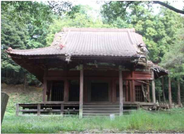
善光寺本堂（屋根が重みで一部崩壊している）
